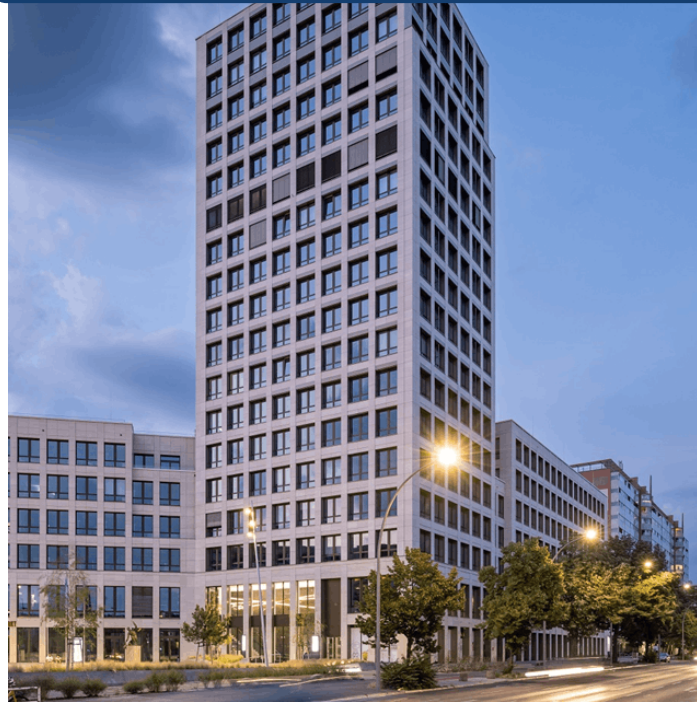
Frankfurter Allee, DE Bauzeit 2017 - 2021
