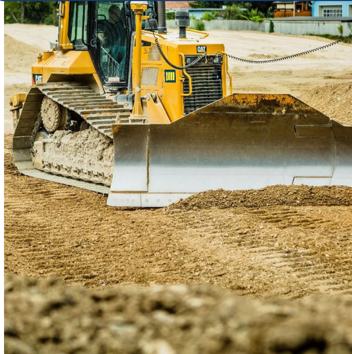
Erdbau HWRHB Fahrafeld, AT 2020-2023
