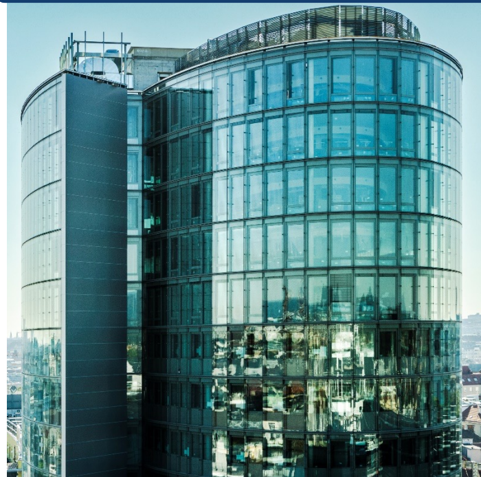
Vio Plaza Wien, AT Bauzeit 2020 - 2023
