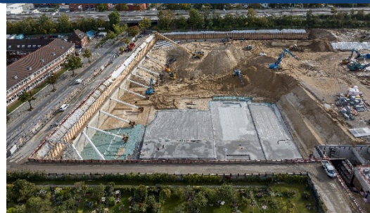
Spezialtiefbau Gewerbehöfequartier Go West
