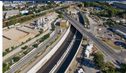
Verkehrswegebau A100 Berlin
