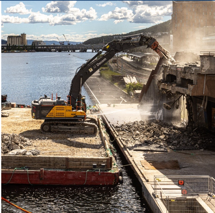
Abbruch Brücke Drammen, NO 2022
