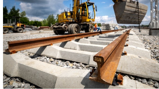
Bahnbau Leitstelle Bytom
