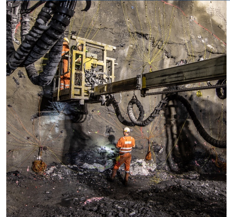
Brenner Basistunnel H53, AT Bauzeit 2018 - jetzt
