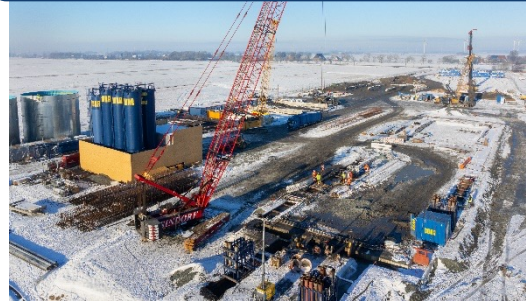
Tiefbau Südlink ElbX
