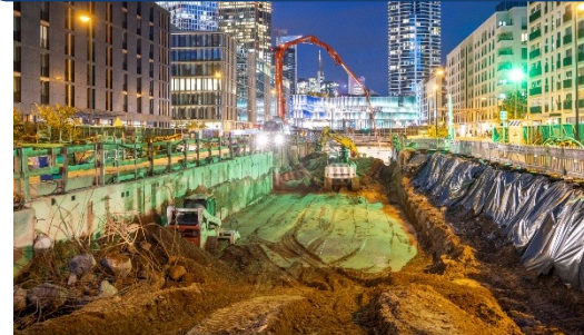
Ingenieurbau U5 Europaviertel
