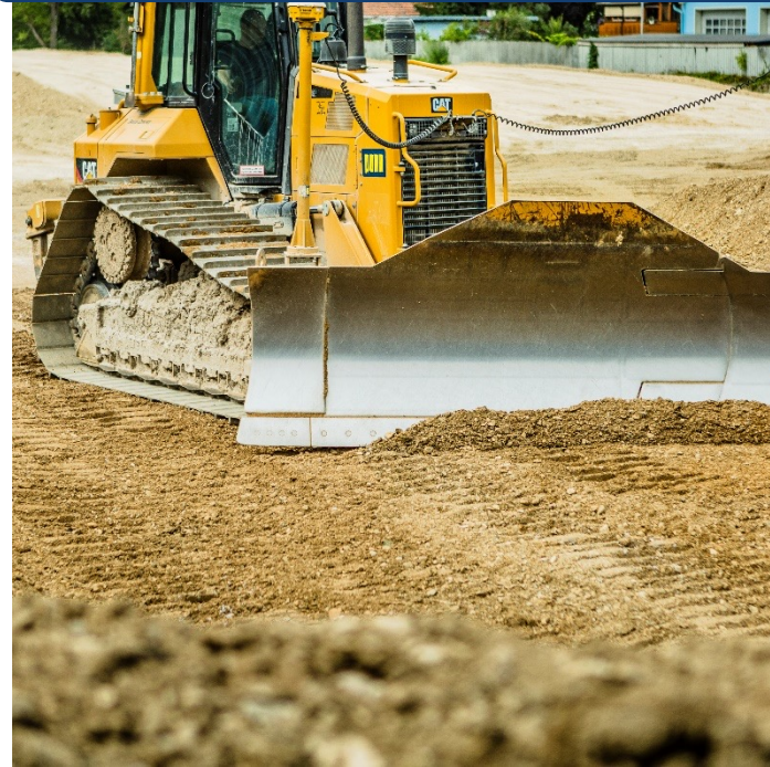
Erdbau HWRHB Fahrafeld, AT 2020-2023
