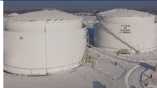
Industriebau Kraftstoff Tanks Boronow
