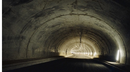
Tiefbau Tunnel TS 26
