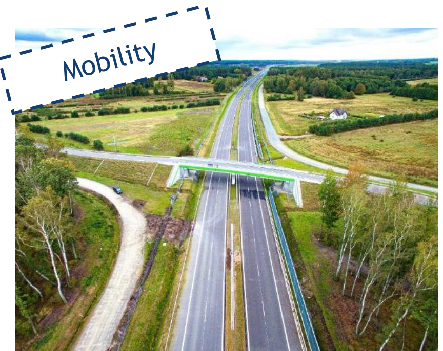
S19 expressway Kuźnica - Sokółka Północ
